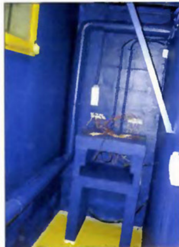
Le mur du local technique et le rack matériel sont fabriqués en béton cellulaire.
